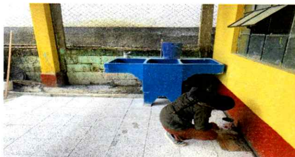
Foto 2: En proceso de instalación de pila nueva.
