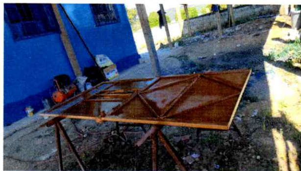
Foto 3: Reparación y adaptación de puerta.
