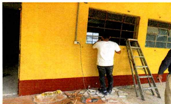
Foto 8: Vidrios deteriorados e incompletos en proceso de sustitución por vidrios nuevos.
