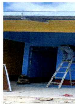
Foto 14: Puertas deteriorada retirara para instalación de puerta nueva en aula 2.
