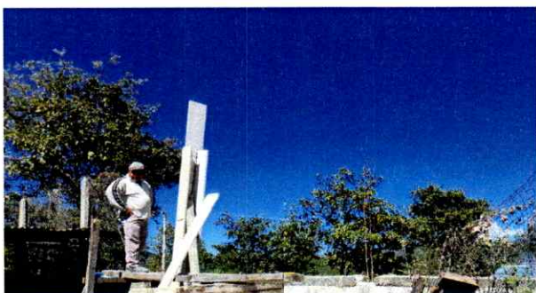
Foto 11: Muro perimetral en proceso, construcción de columnas e instalación de malla nueva en tramos deteriorados.
