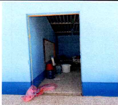
Foto 13: Puertas deteriorada retirara para instalación de puerta nueva en aula 1.
