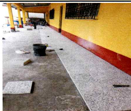
Foto 10: Proceso de colocación de piso de granito en patio.
