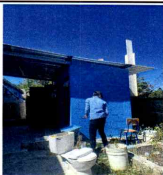
Foto 5: Piso de granito en módulo de baños en proceso de instalación.
