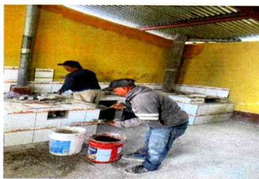
Foto 4: Colocación de piso de granito en módulo de cocina.
